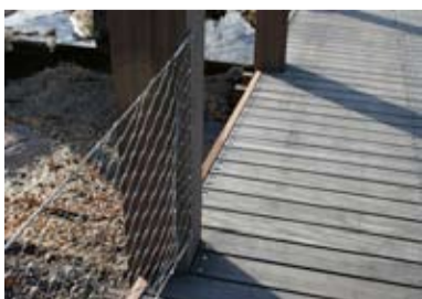
Skyddsnet. Stabila nät skyddar vid innerkanten på bryggdäcket.
