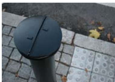
Riktning. Låga stolpar visar synskadade riktningen vid övergångsställen.
